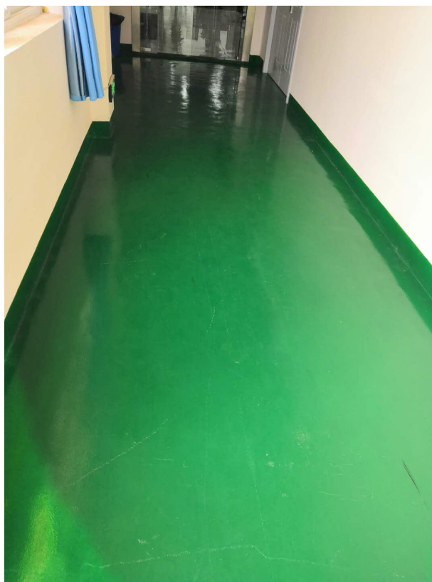
图 4-7 项目防渗地面
